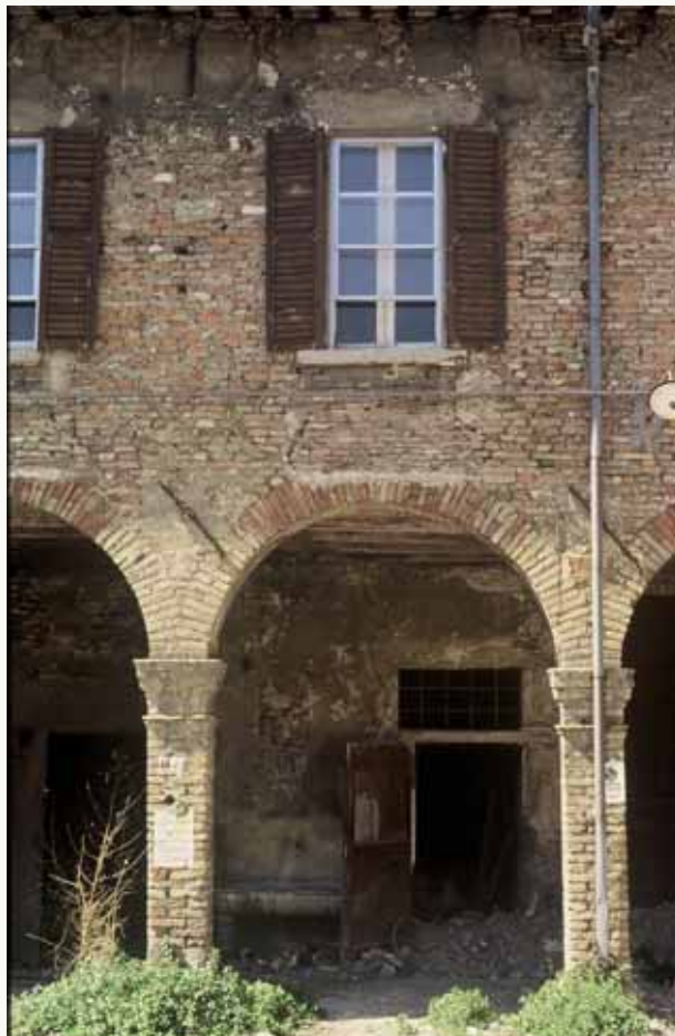
Il porticato ottocentesco dell'antico ospedale di Santa Maria della Misericordia, ora sede della Provincia di Rimini, prima dei restauri degli anni 1999-2000.
